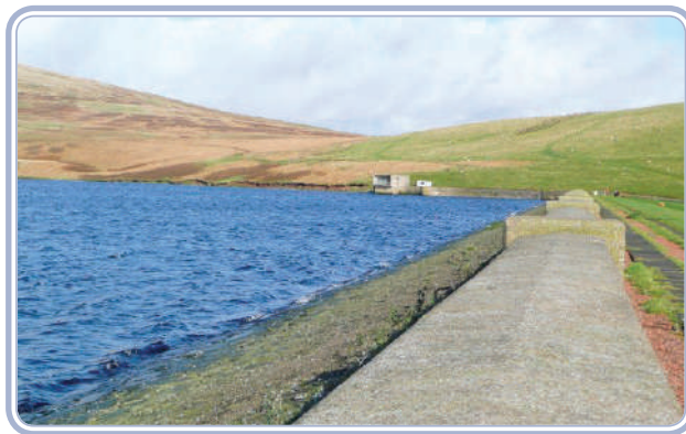
Figura 5.2: Reservatório de água
