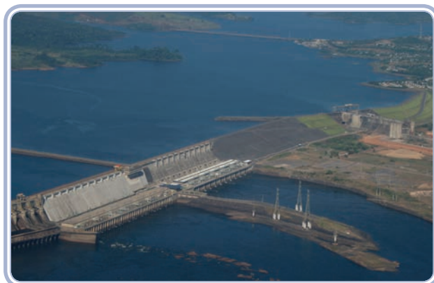
Figura 5.3: Usina para geração de energia
